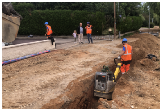
Remplacement de la conduite d'eau potable
